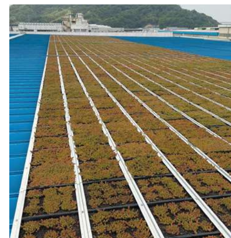
広島県某物流施設 / 3401.3㎡
