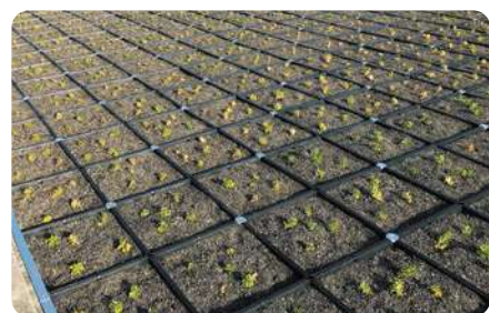
大阪府某工場 2020年 11月施工
