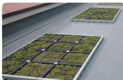
大阪府某商業ビル 2019年 2月施工
