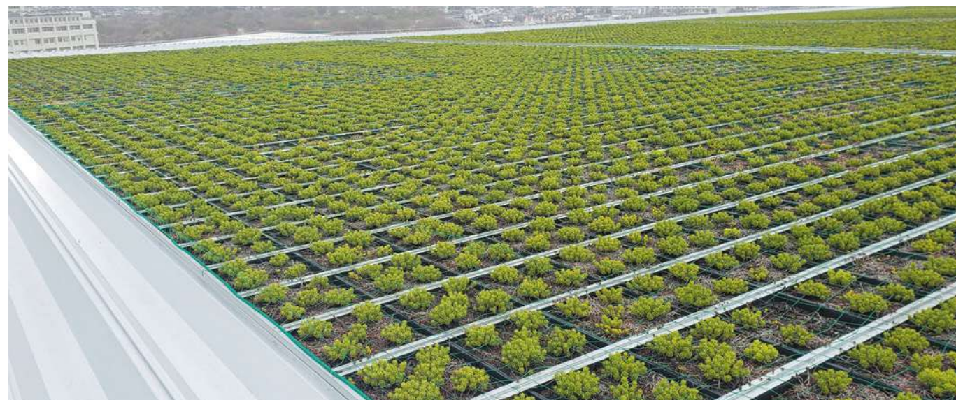
東京都某物流施設 / 2240.0㎡
