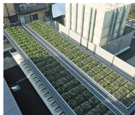
兵庫県マンション駐輪場 / 36.0 ㎡
